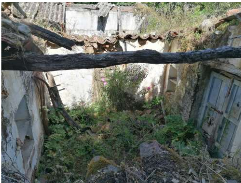
VISTA INTERNO CUCINA
